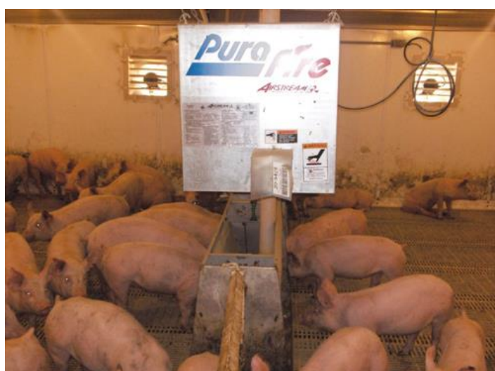
Рисунок 2.38 – Использование газовых теплогенераторов GSI в секторе поросят на дорастивании
